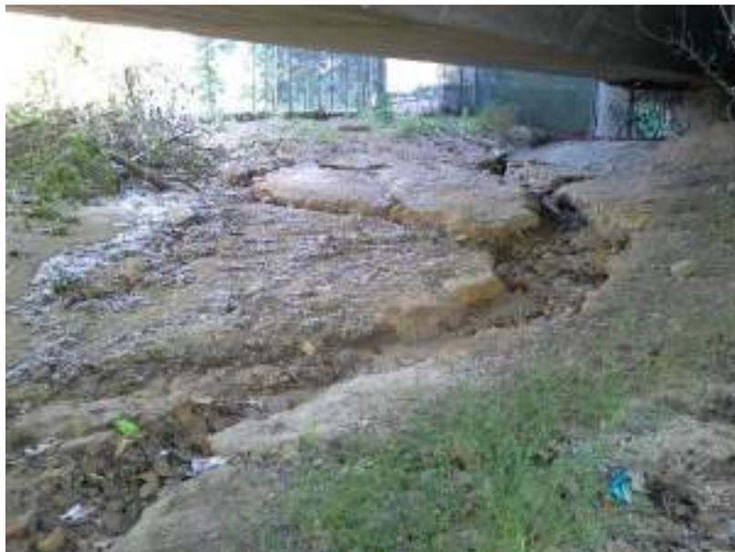
*Figura 33. Cárcava que se debe rellenar y compactar (zona 3)*
