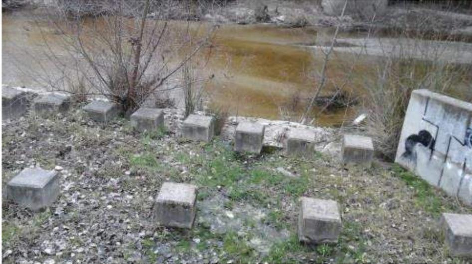
*Imagen 24. Disipadores en colector*
