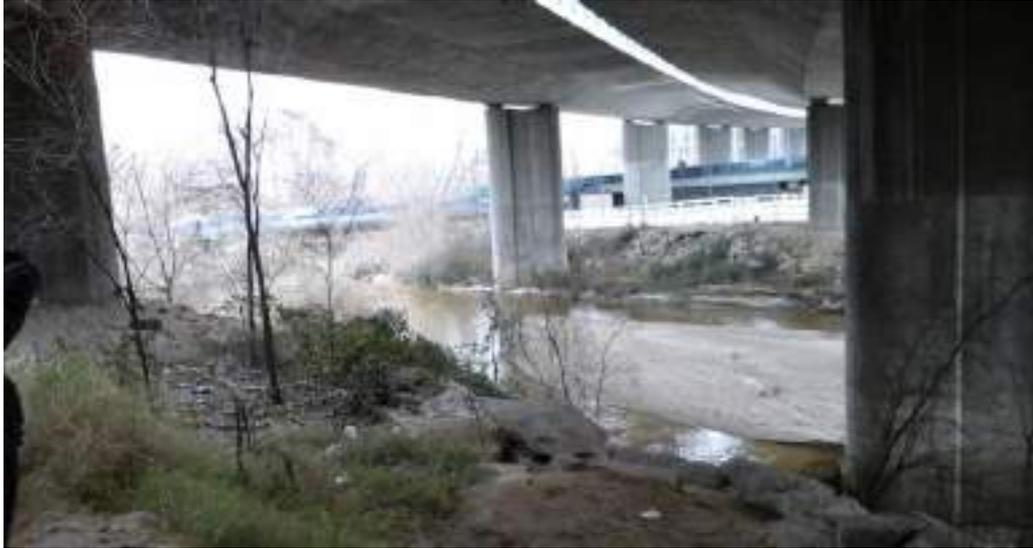
*Imagen 28. Presencia de sedimentos en torno al puente de la M-40*
