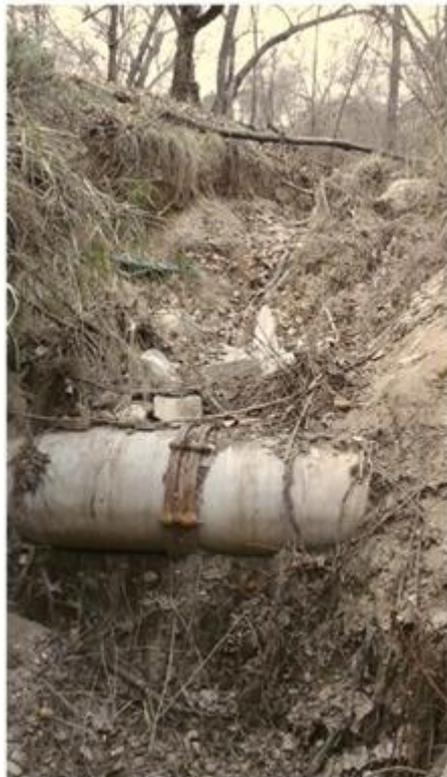
*Figura 41. Cárcava que se debe rellenar y acondicionar (zona 4)*
