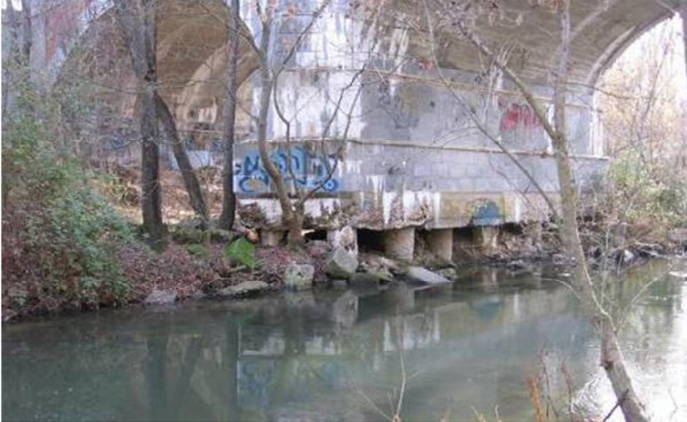
**Ilustración 2:** Puente de los Capuchinos en su situación actual (2015). Se observa el grave problema de incisión existente en el cauce, con un descenso del nivel del río de varios metros.
