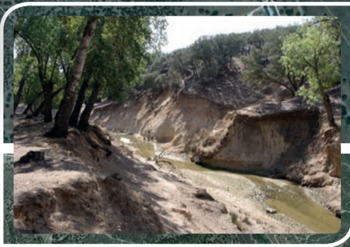
Fuerte erosión en el valle del arroyo de la Trofa
