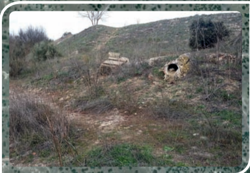
Escombros en la zona de Mingorrubio para retirar
