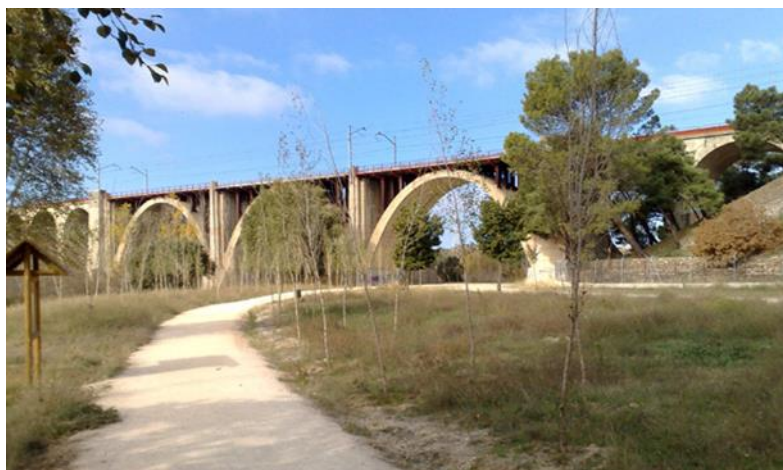
Imagen 5. Corredor ambiental del río Manzanares a su paso por el puente del ferrocarril
