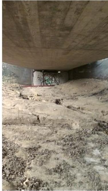
Imagen 7. Pilastras de vías de comunicación
