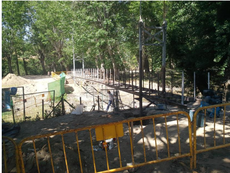
Imagen 11. Puente de cables en restauración en P.D. Puerta de Hierro
