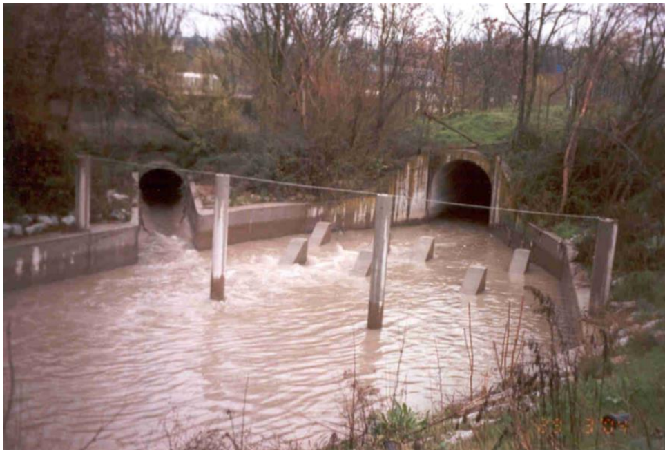
Imagen 2. Aliviadero de Fuentelarreina vertiendo (Fuente: Ayto. Madrid)
